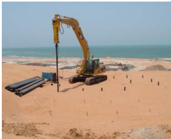
Fig. 1 - Cravação de estacas
