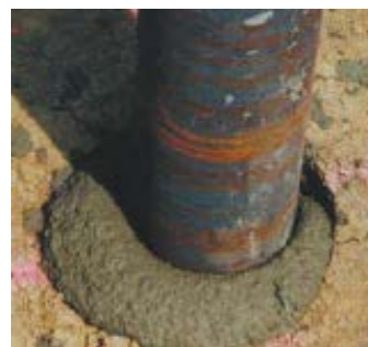
Fig. 6 - Cravação de estaca com injeção simultânea
