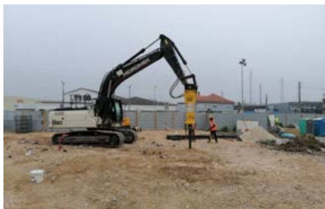
Fig. 8 - Cravação de estacas - LIDL Aveiro
