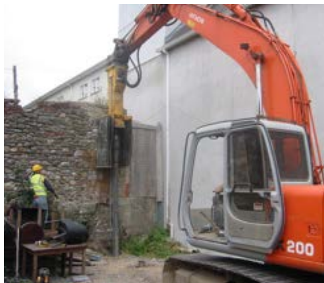
Fig. 9 - Cravação de estacas junto a um muro
