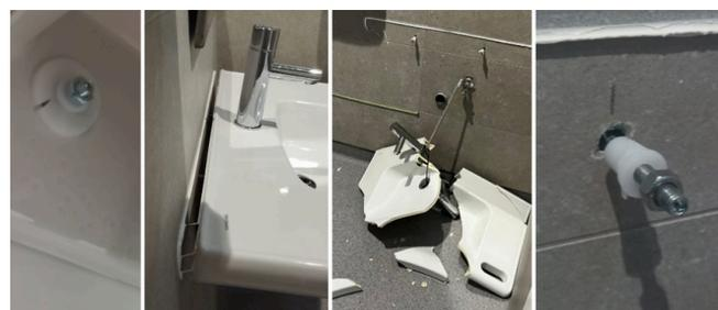
**Figura 7:** Evolução duma situação de rotura da fixação de um lavatório suspenso.
