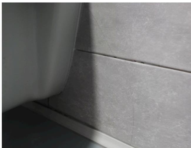
**Figura 2:** Ladrilho quebrado no tardoz de uma sanita suspensa.
