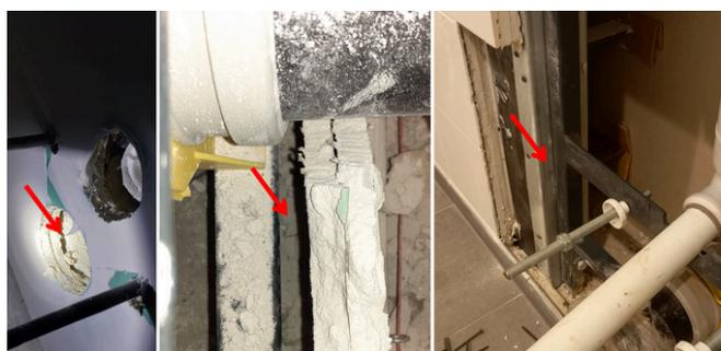
**Figura 4:** Exemplos de instalações com folga entre a estrutura de suporte e as placas de gesso cartonada da parede.
