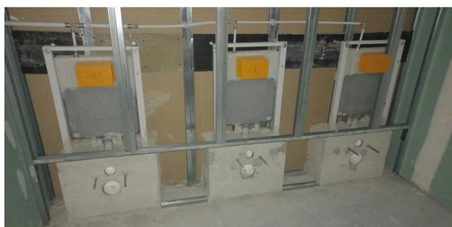
**Figura 5:** Reforço por maciçamento de volume inferior de estruturas de suporte de sanitas.
