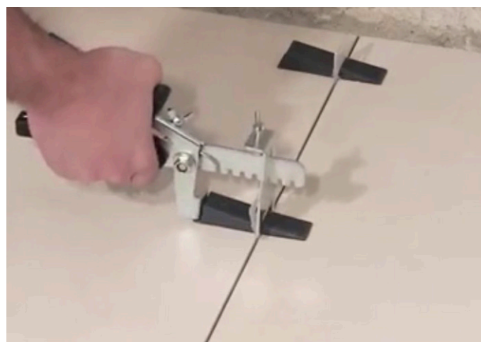
Figura 4 - Colocação de espaçadores
