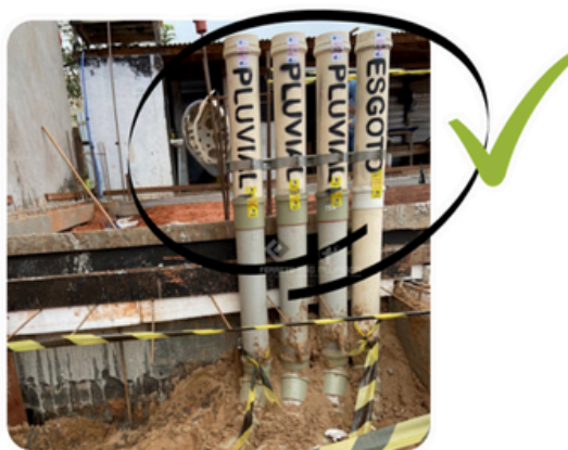
Figura 8: Identificação de tubagem em espera (5).
