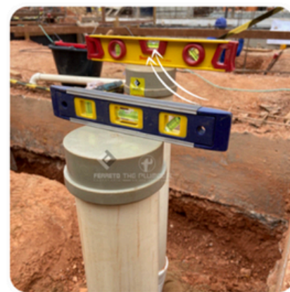
Figura 9: Proteção/tamponamento de tubagem em espera (5).
