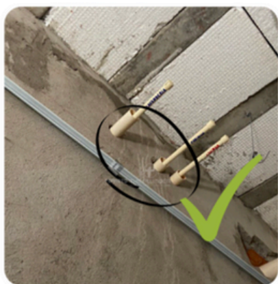
Figura 7: Atravessamento de tubagem protegido (5).
