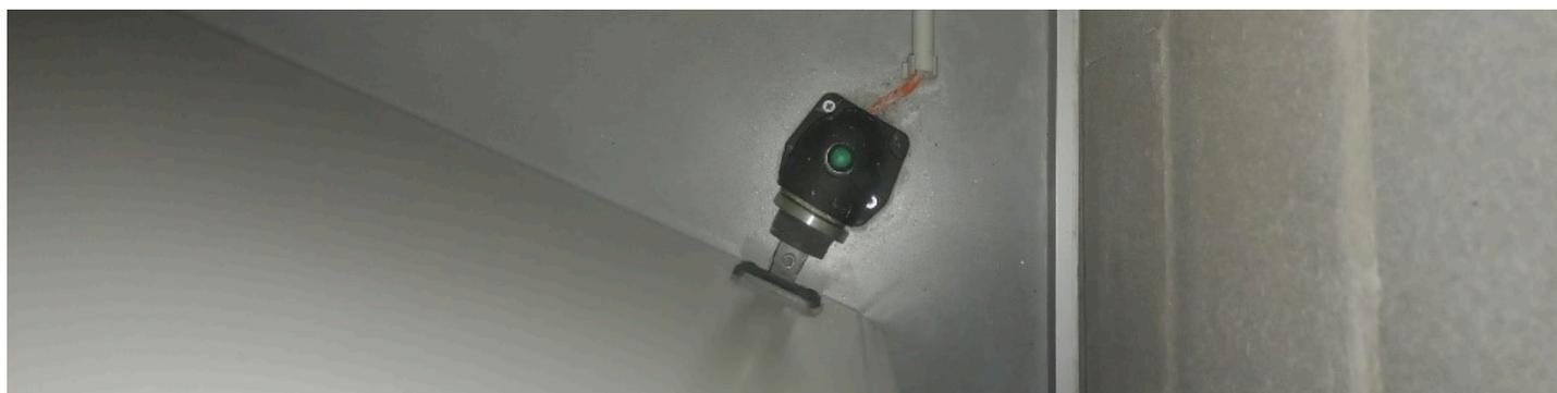
**Figura 4:** Exemplo de retentor eletromagnético em funcionamento
