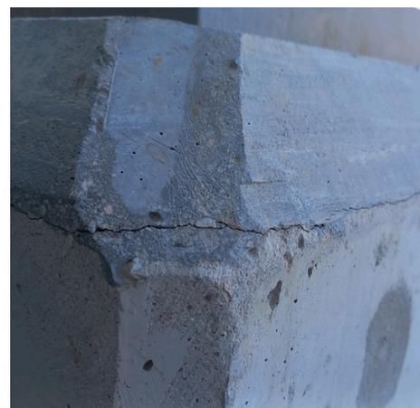
**Figura 3:** Fissura na transição entre o betão e o grout.
