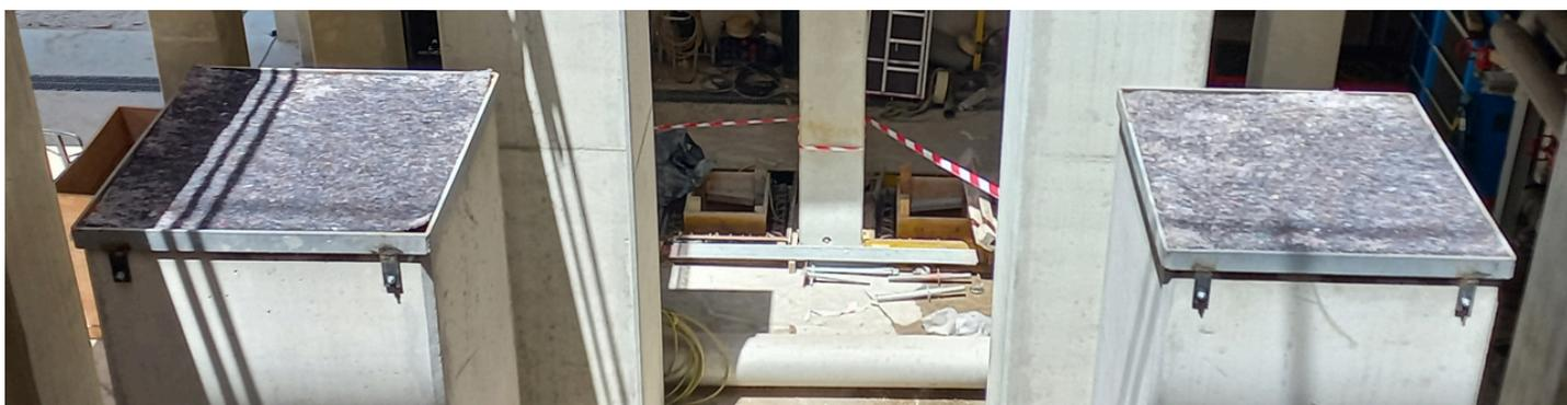
**Figura 7:** Cura grout aplicado em maciços, com recurso a geotêxtil permanentemente humedecido.
