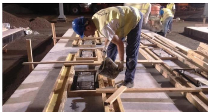
**Figura 6:** Aplicação de grout por vazamento.
