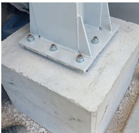
**Figura 1:** Maciço de betão com acabamento liso na futura superfície de contacto com o grout.
