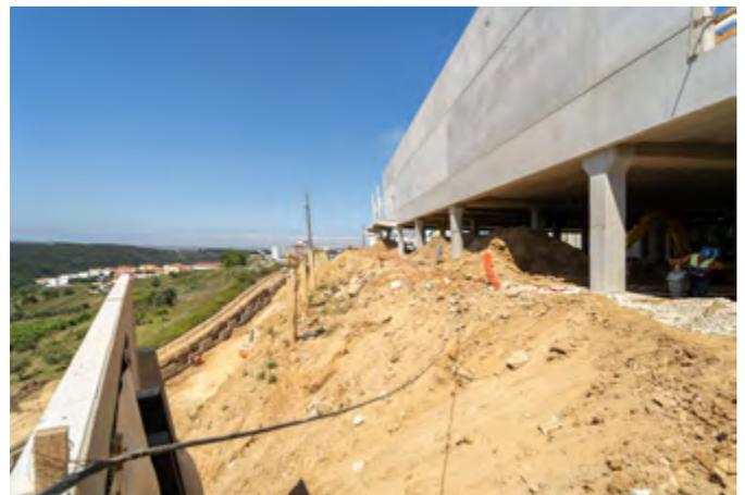
Para isso, adotou-se o processo de fundações indiretas com estacas cravadas. “Este processo conferiu à obra a agilidade necessária para que a conclusão do muro de terra armada ocorresse em simultâneo com a montagem de toda a estrutura pré-fabricada da loja.
